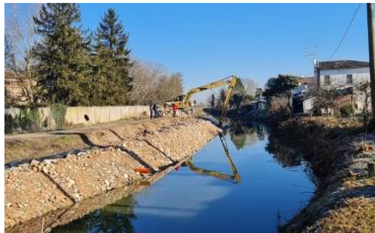
Una delle zone inserite nell'elenco delle aree in cui sono previsti gli interventi di ripresa delle frane. Ecco l'elenco dei lavori
